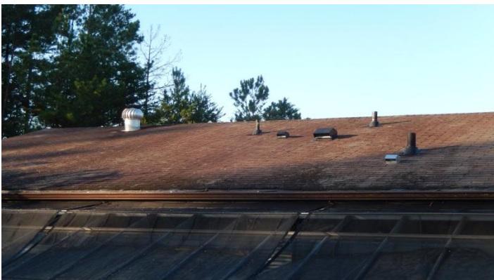
지붕 공사 하기 이전
