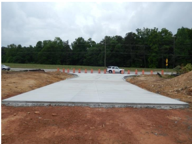
진입로 와 주차장 사이 진입로 공사 완료 (5 월 9 일)
