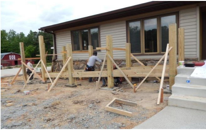
ADA Ramp (장애인용 Slope) (5 월 9 일)
