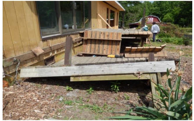
호수쪽을 향한 거실 뒷쪽에 위치한 Deck 공사 I (5 월 12 일)
